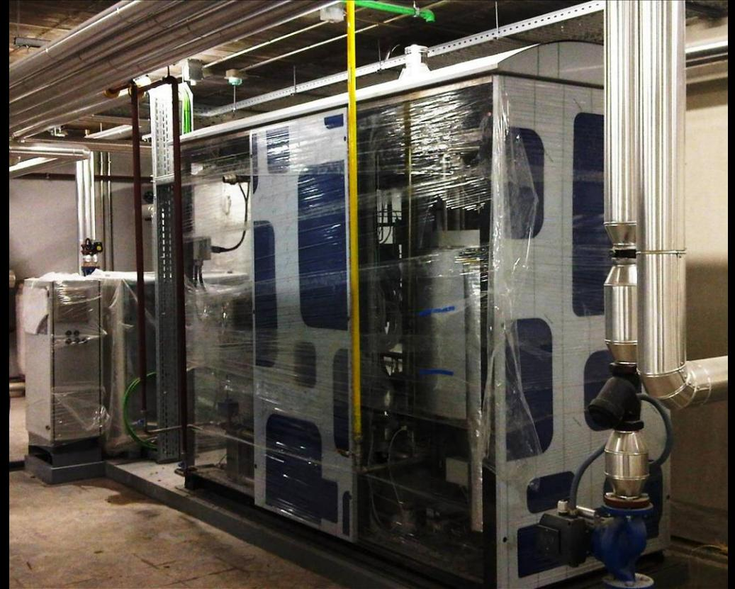
1. Desulfurador: depuración del gas natural eliminando componentes de azufre
