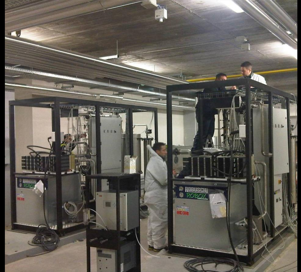
Como subproducto del proceso obtenemos energía térmica en forma de agua caliente (75-85° C).
