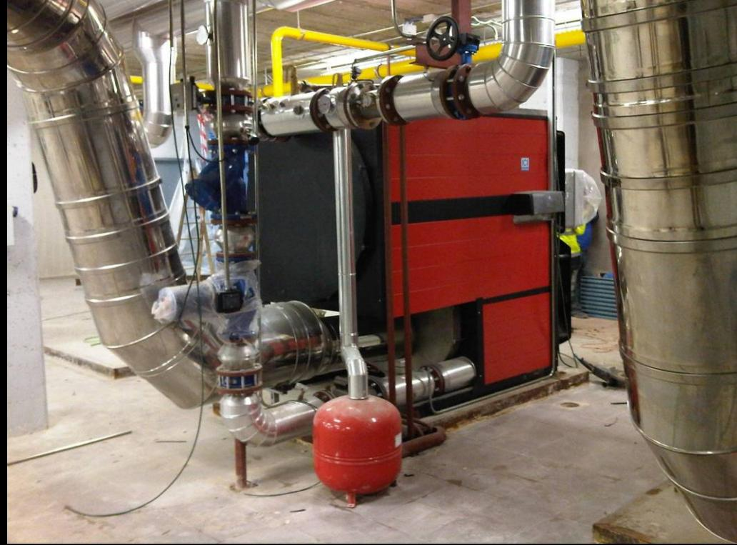
El Sótano 2º se sitúan las pilas de combustible, las cuales transforman el Gas Natural en energía eléctrica, recuperándose el calor residual producido para la planta de producción de calor.
