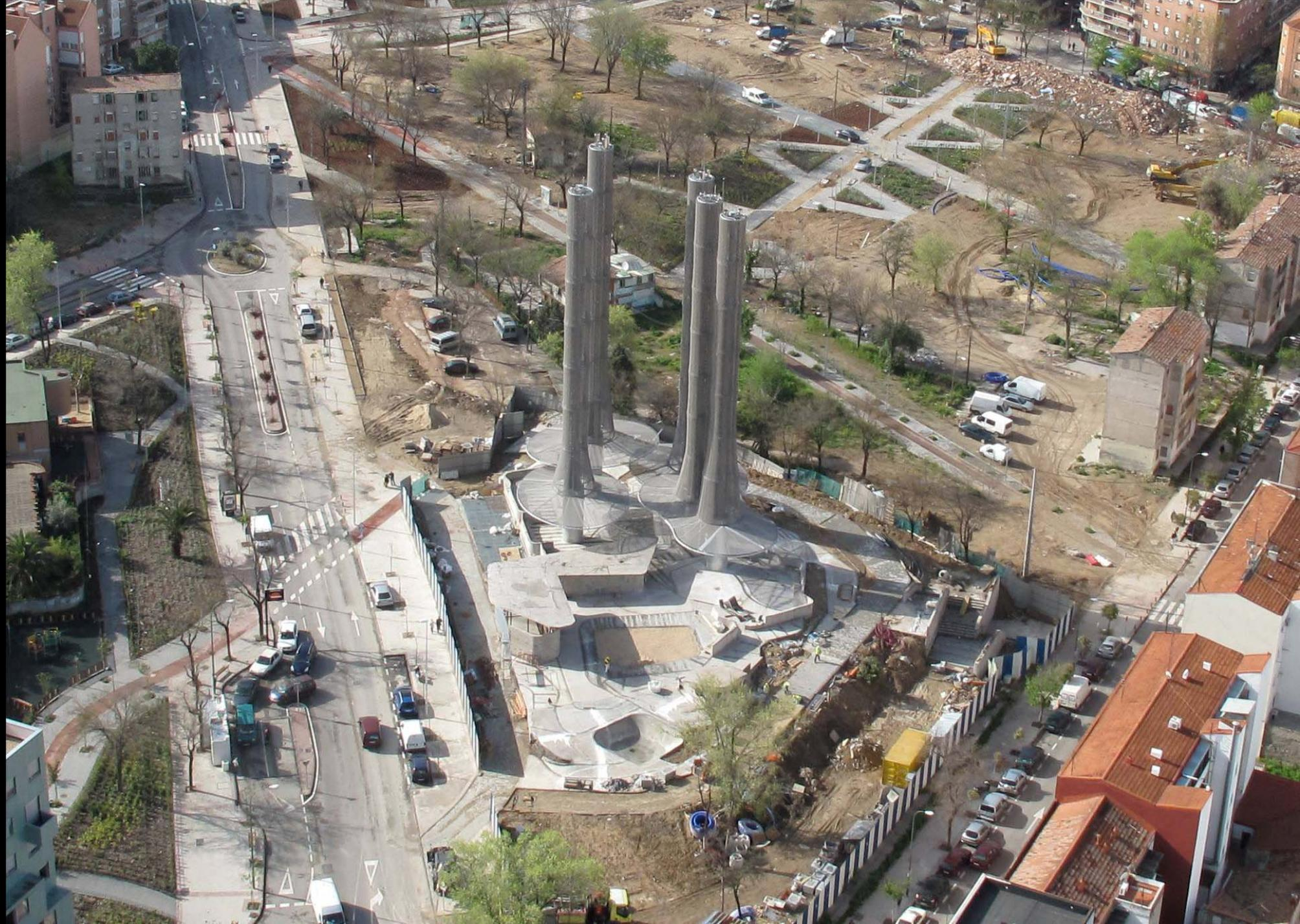
**Las dos instalaciones cuentan con cinco chimeneas de unos 40m de altura para la salida de aire caliente de la central de residuos y de los gases de combustión producidos en la central de calor.**
