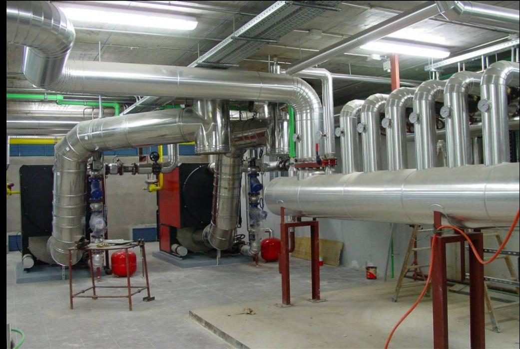
En el sótano 1º se sitúan los seis grupos térmicos de condensación a gas (instalados los dos primeros) que, conectados en paralelo, proporcionan una potencia total instalada de 9.600 KW. (8,2 millones de kcal.)
