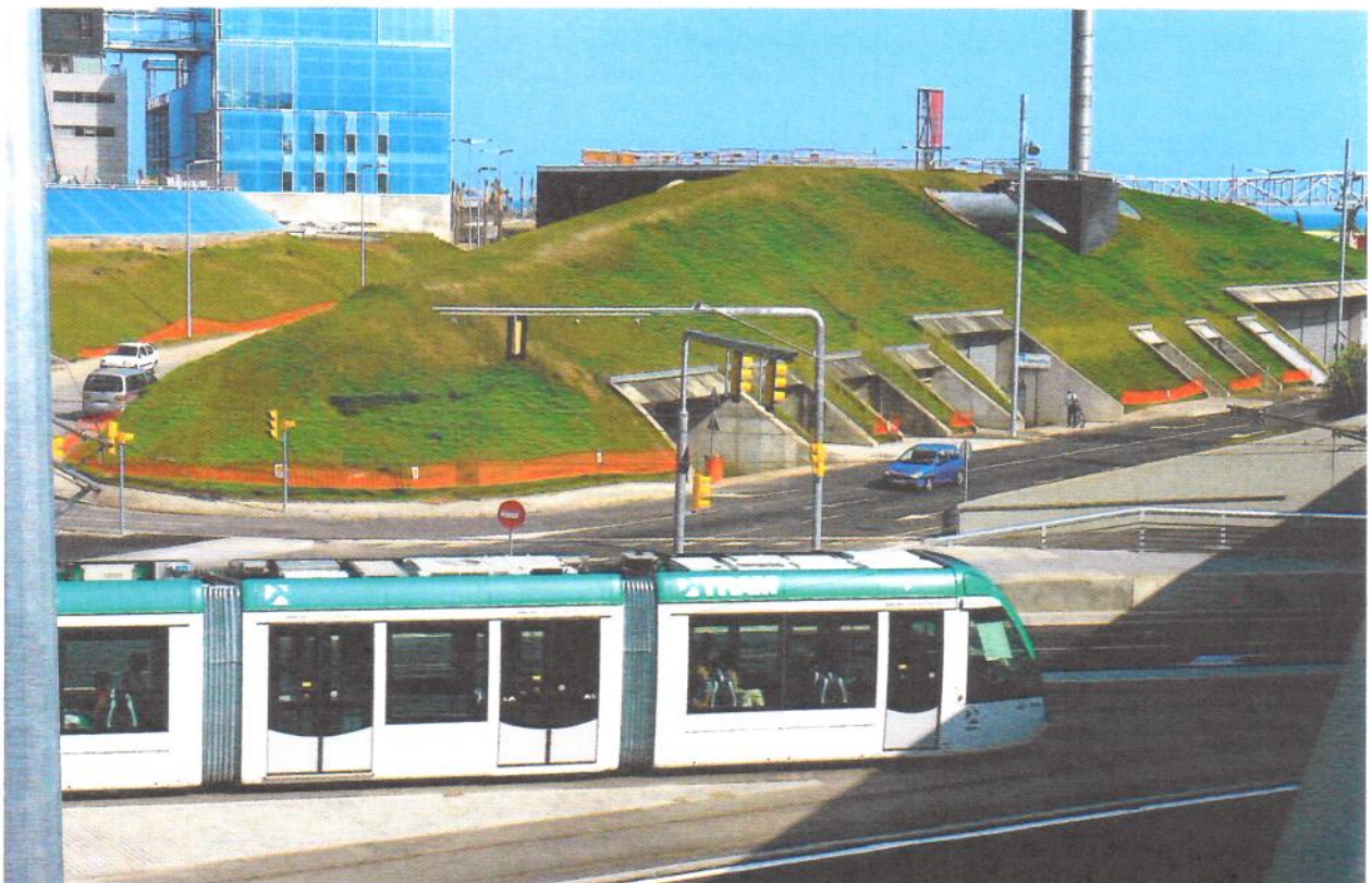
I Barcelona er denne varme/kølecentral blevet indarbejdet i landskabet og dermed et ganske diskret eksempel på, at fjernvarme og fjernkøling er ved at vinde indpas i Spanien. Foto: Josep Loaso.
