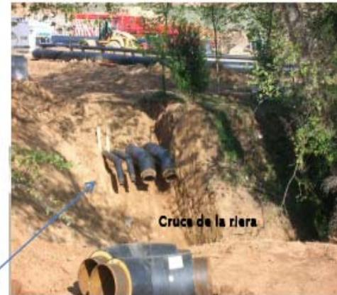
Detalle del sellado de los manguitos termoretráctiles en las soldaduras de tubería
