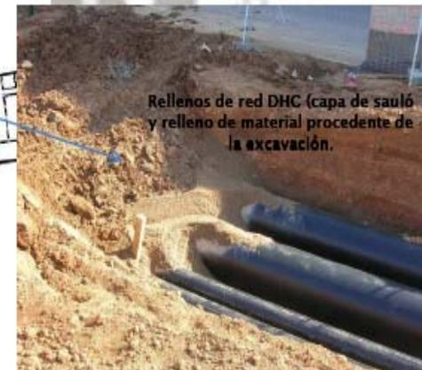
Actualmente se está ejecutando la canalizaciones a CELLS, se trata de una zanja de unos 400 metros de longitud y con las secciones constructivas detalladas
