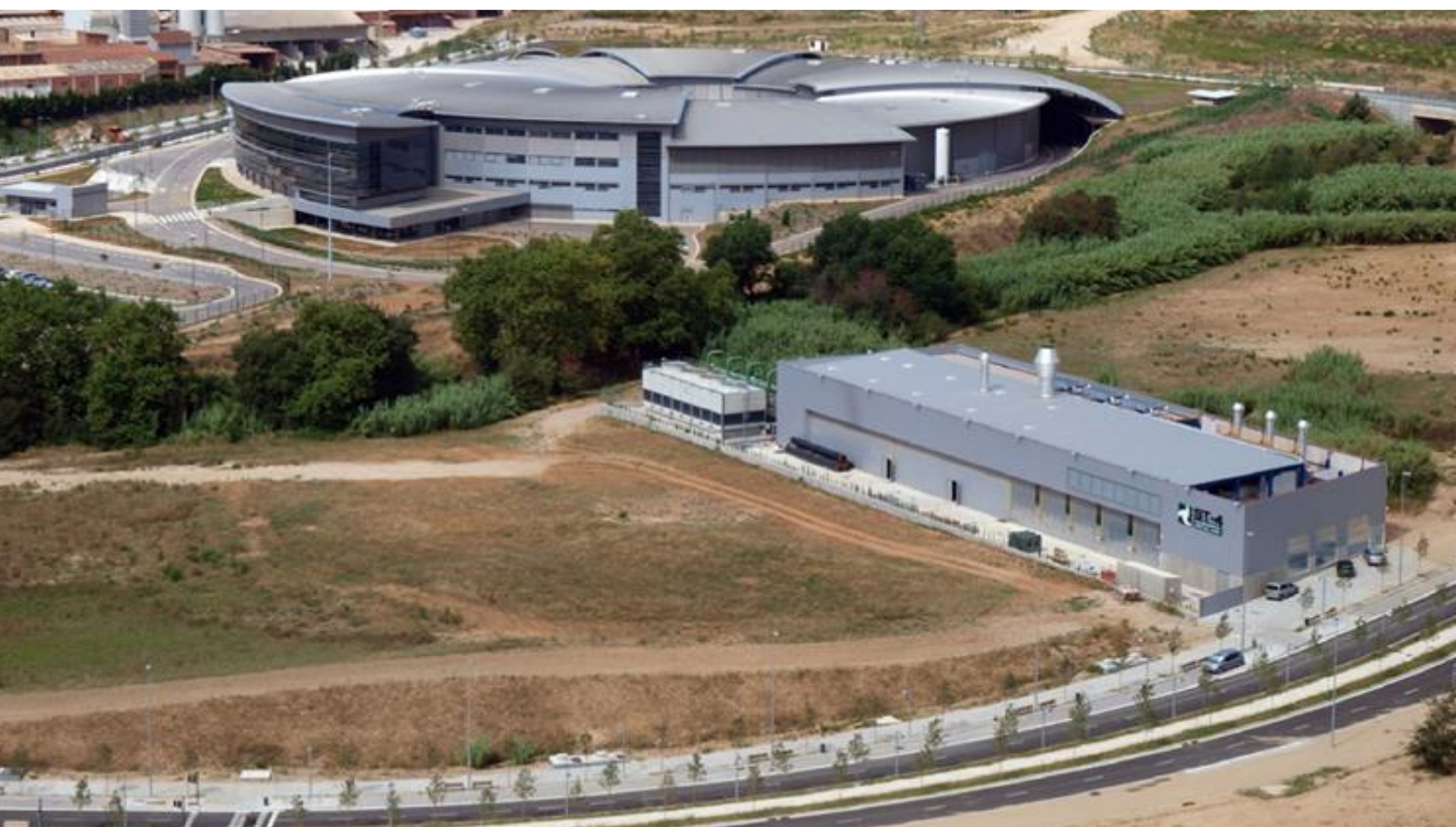
Red de calor y frío ST-4 del Parque de la Ciencia y la Tecnología de Cerdanyola del Vallés
