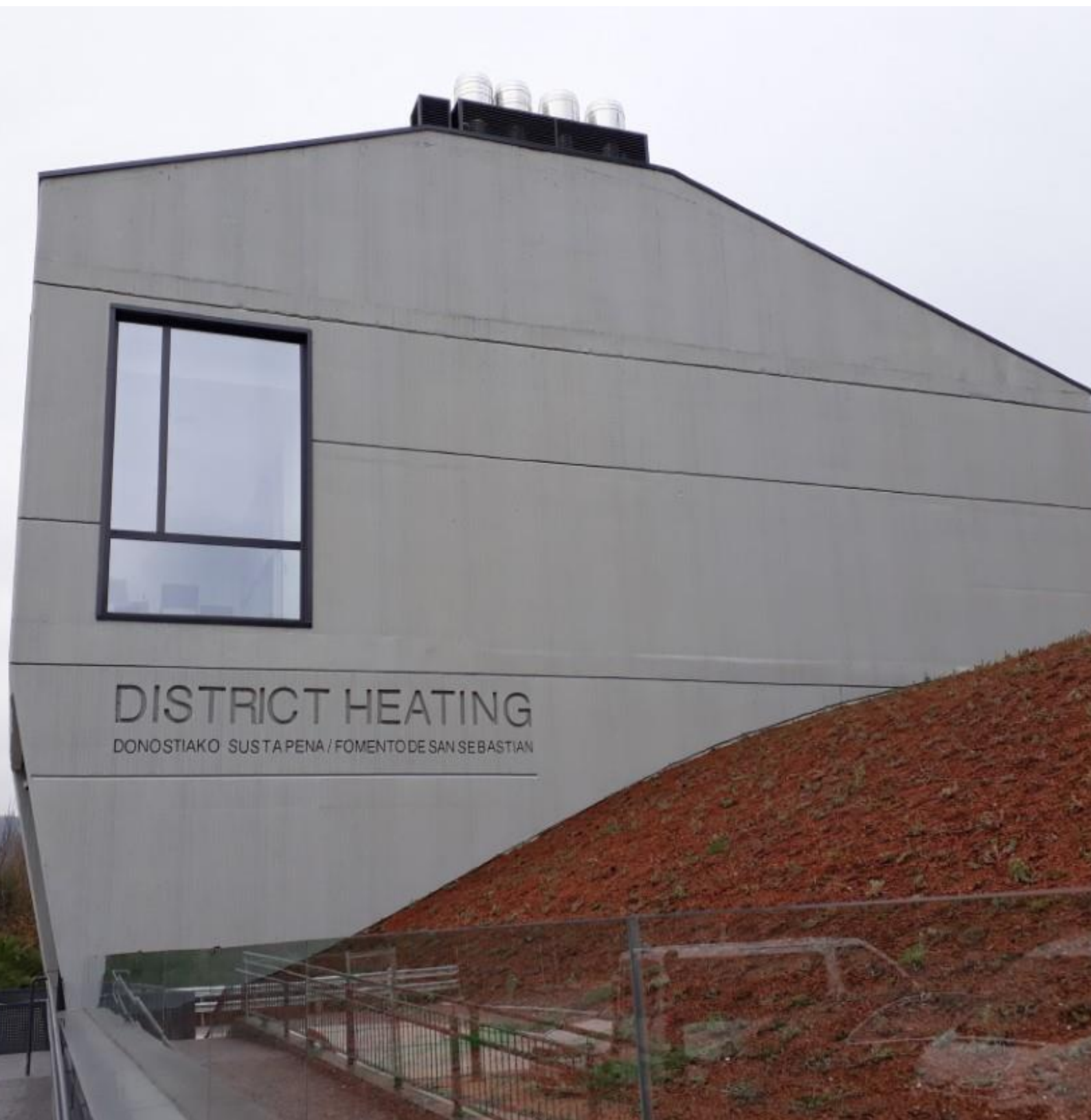
Central de generación de calor de la red de calor Txomin-Enea, en San Sebastián
