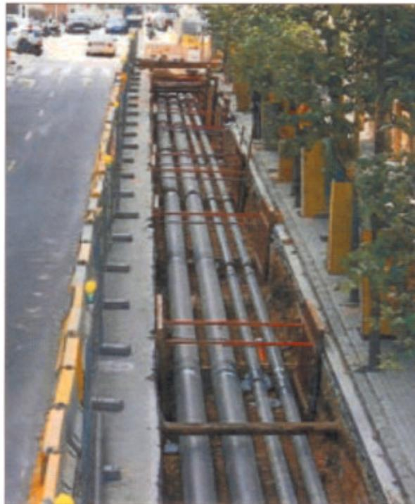
Obras de la instalación subterránea de la red de calor y frío en la calle Zamora.
