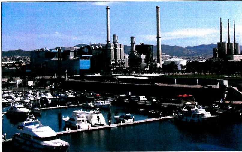
Figura 32.5. Vista exterior de la planta de tratamiento de residuos sólidos urbanos. Fuente: A. Ivančić.
