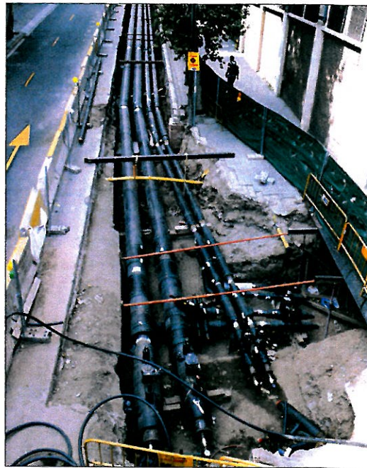
Figura 32.3. Montaje tuberías preaisladas.
