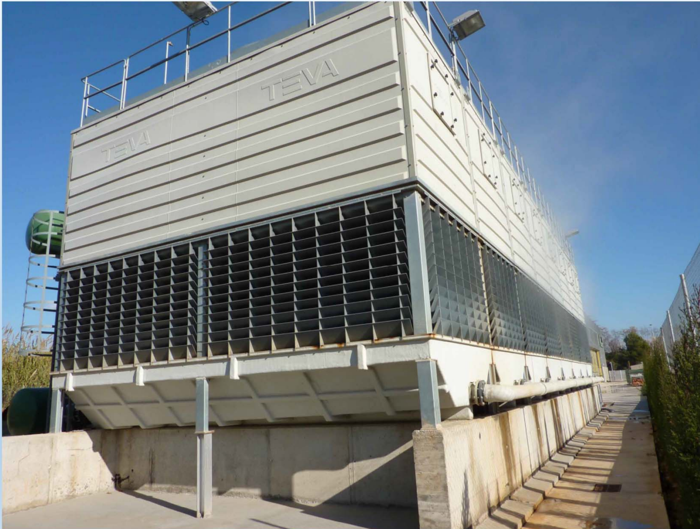
Torre de refrigeració con una capacidad de 22 MW
