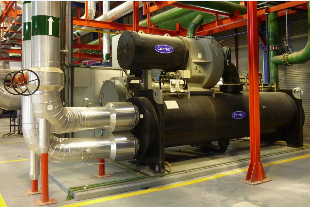
Enfriadora de compresió Carrier 19XR8587
