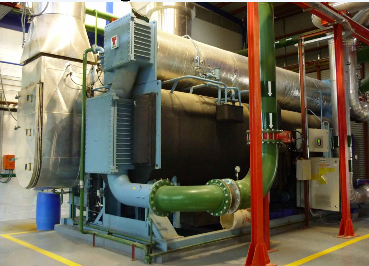
Thermax ED 80C CX enfriadora de absorción de doble efecto
