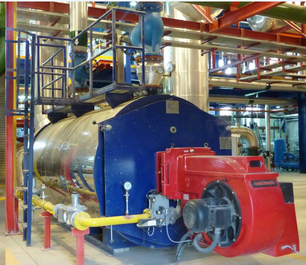
Caldera convencional de 5.000 kWh
