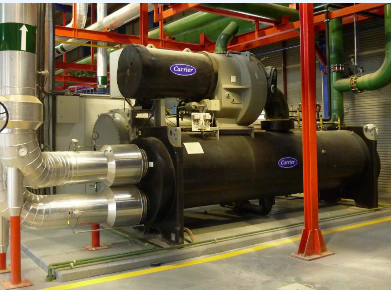
Compressor de compresió Carrier 19XR8587
