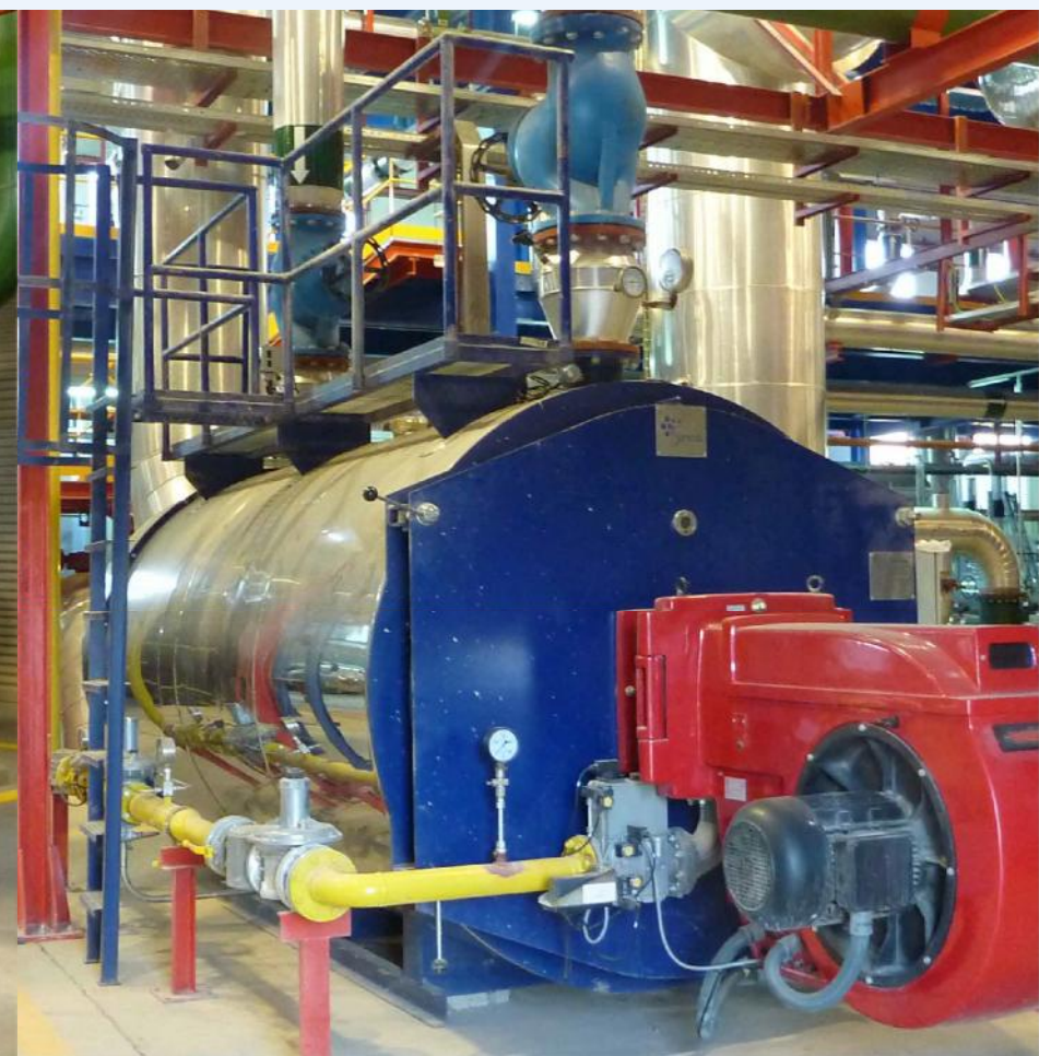
Caldera convencional de 5.000 kW
