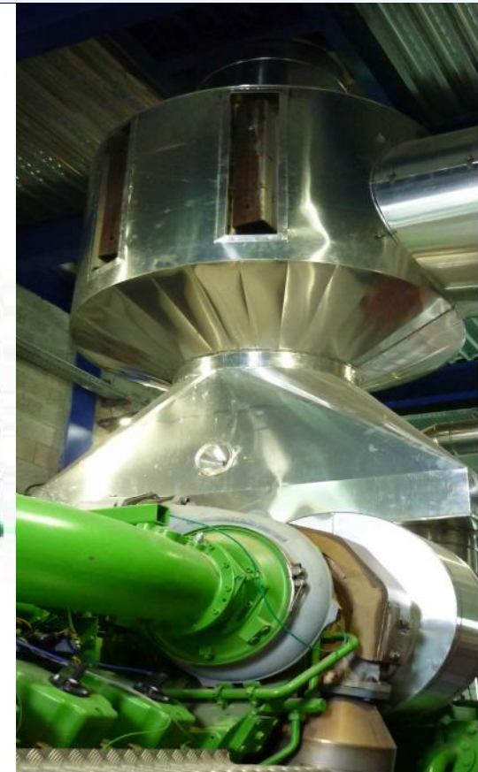
Salida de gases de escape de un motor
