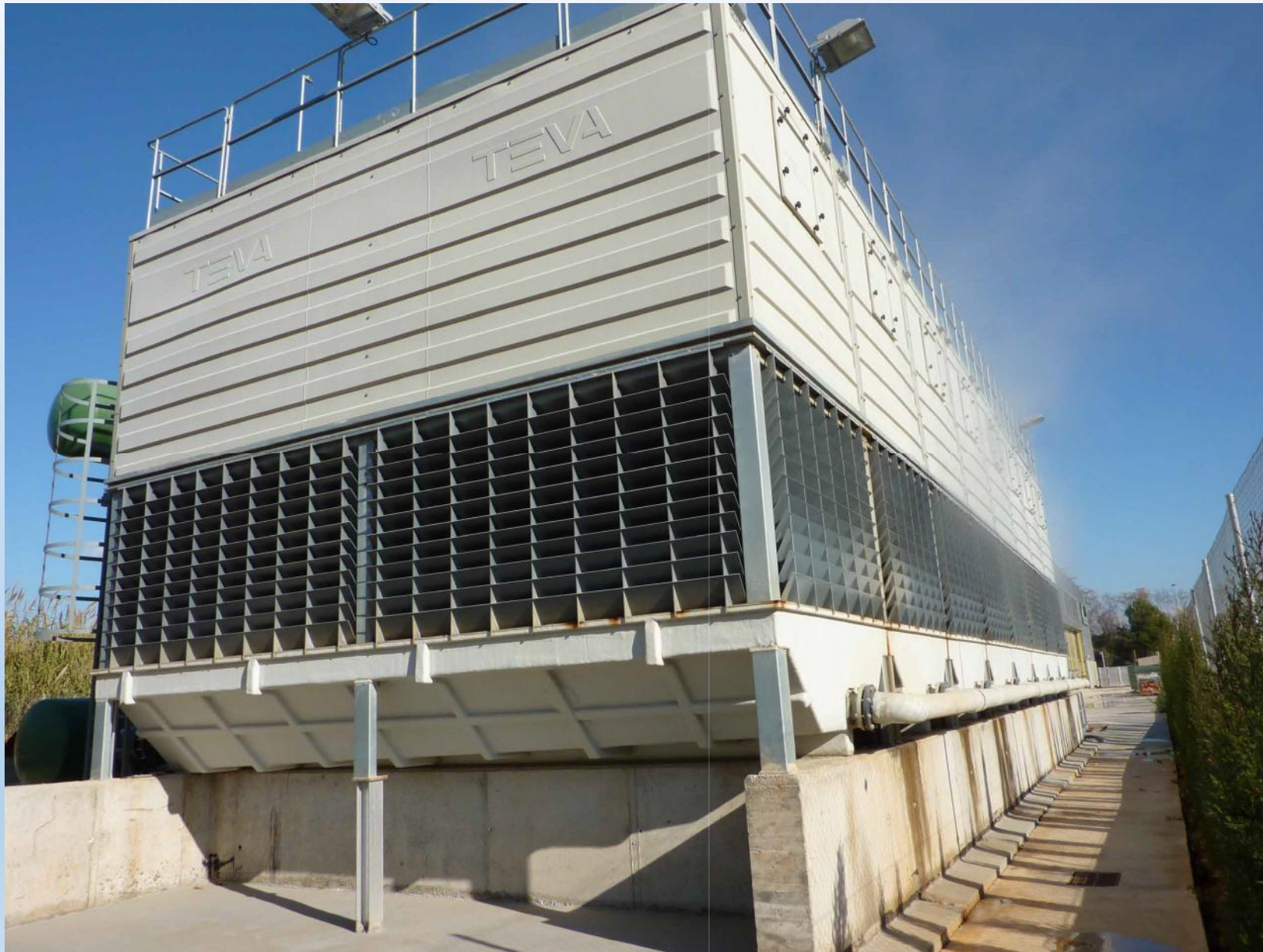
Torre de refrigeración con una capacidad de 22 MW
