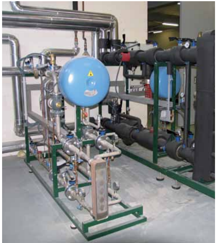
Instal·lació de connexió del Tub Verd de Mataró
