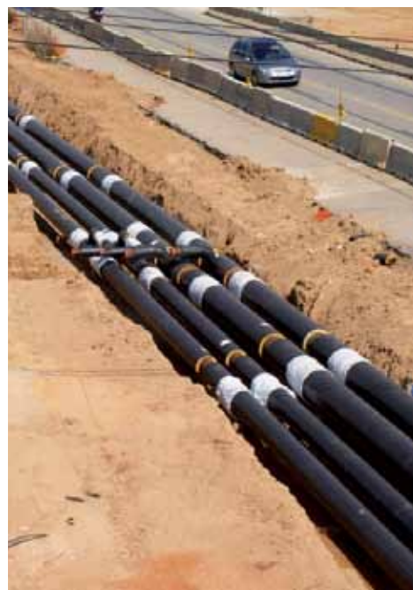
Rasa de canonades de xarxa de districte
