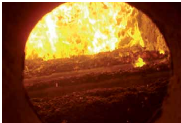
Forn de valorització de biomassa
