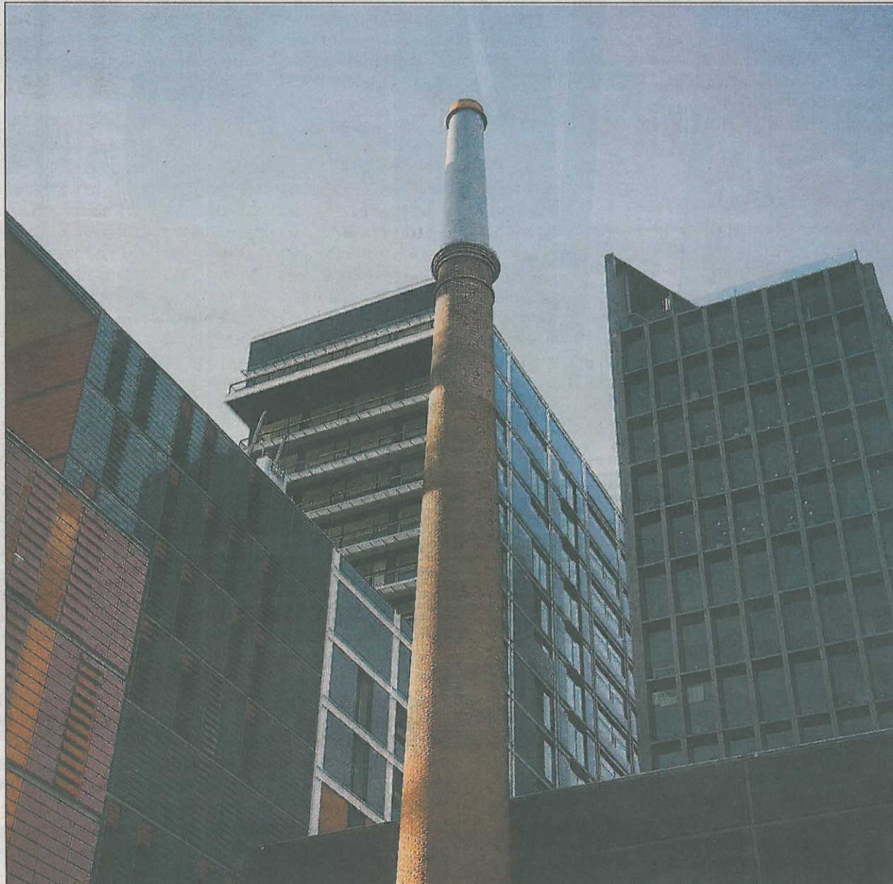
Imagen de la chimenea de Ca l'Aranyó conectada a la central de Tánger.
