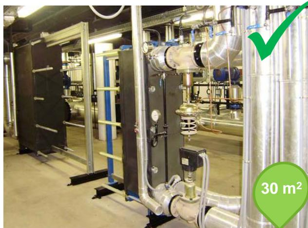
*Un edificio de unos 10.000 m<sup>2</sup> pasa de precisar en sala técnica de aprox. 200 m<sup>2</sup> a **tan sólo 30 m<sup>2</sup>** con DHC, destinando esos nuevos m<sup>2</sup> a otros usos.*
