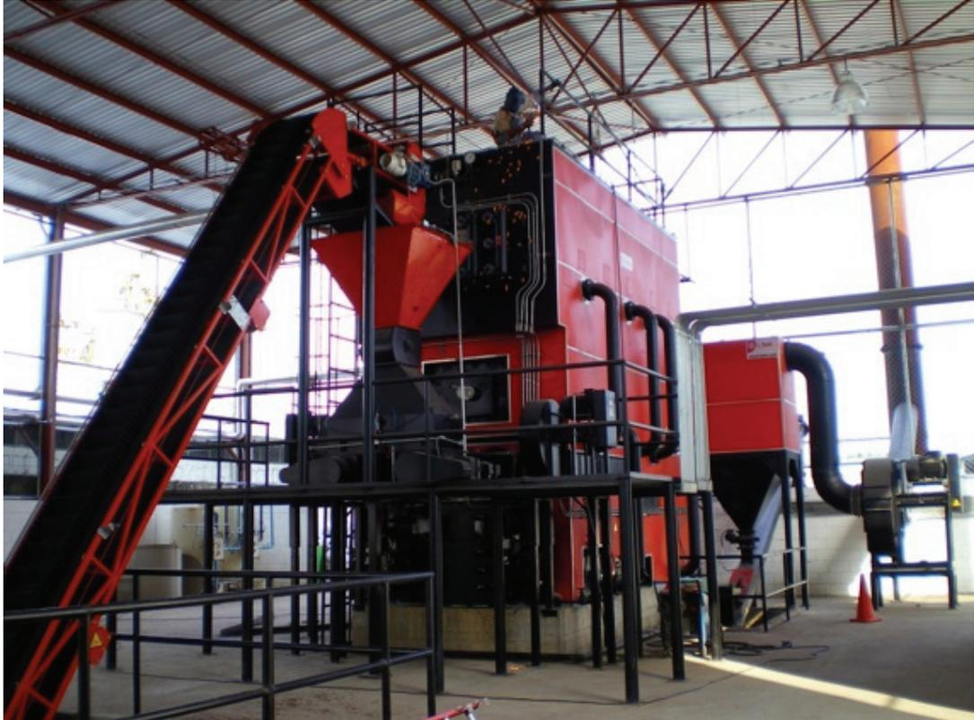
Figura 20. Caldera de biomasa para la generación de 9 t/h de vapor a 10 bar.
