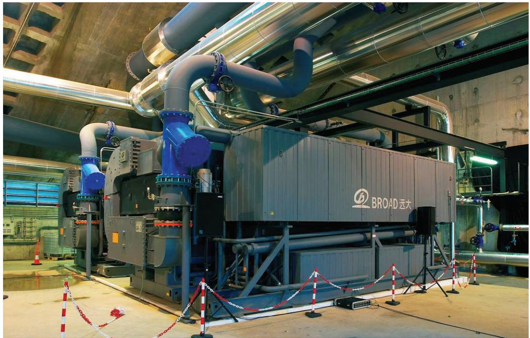
Figura 28. Central Fòrum: máquina de absorción de doble efecto de 4,5 MW y accionada mediante vapor a 8 bar [DISTRICLIMA].
