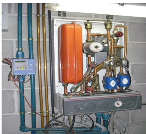
Figura 11. Subestación de DH de Molins de Rei "La Granja".
