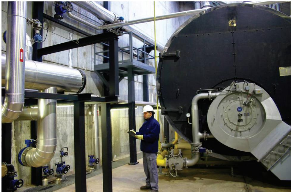
Figura 19. Caldera de gas para la producción de vapor [DISTRICLIMA].
