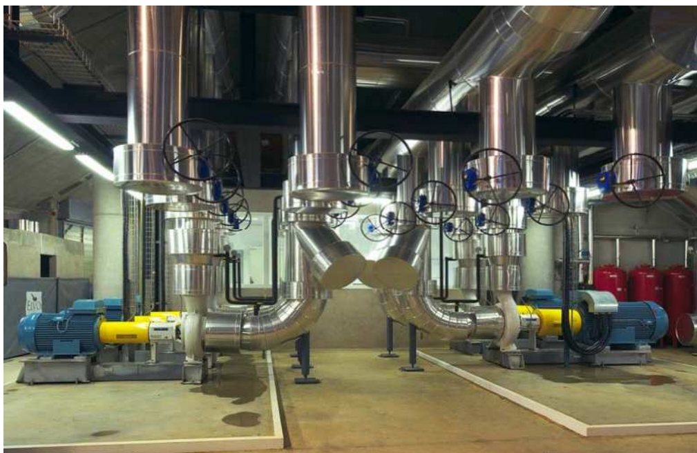
Figura 11. Estación de bombeo del sistema DHC Tub Verd de Mataró (foto superior) y Districlima en Barcelona (foto inferior)
